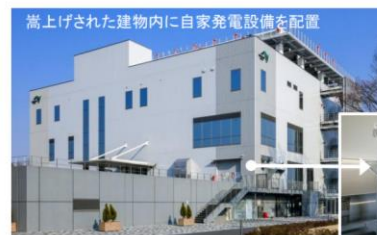
＜自家発電設備等の移設・嵩上げ等の事例＞
