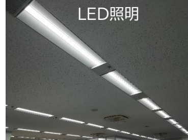
オフィスで使用する照明の取替え (蛍光灯→LEDランプ))
