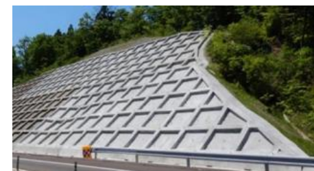
のり面・排水機能の強化対策例
