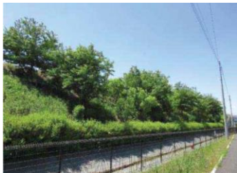
盛土部の植栽状況
