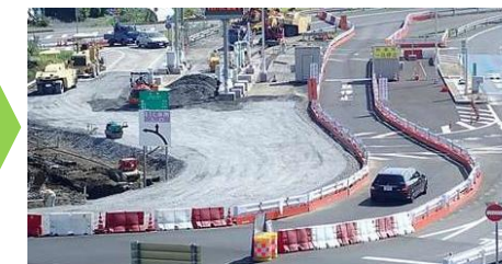
道路面の嵩上げによる浸水被害対策例
