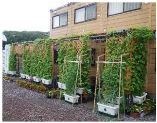
<事例1> 工事現場事務所へのグリーンカーテン設置 (エアコン使用の削減と植物によるCO2吸収)
