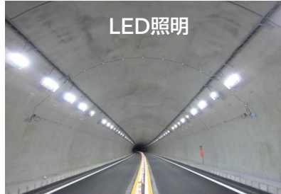
トンネル照明のLED化
