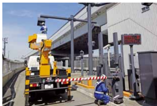
ETC設備点検(アンテナ点検)
