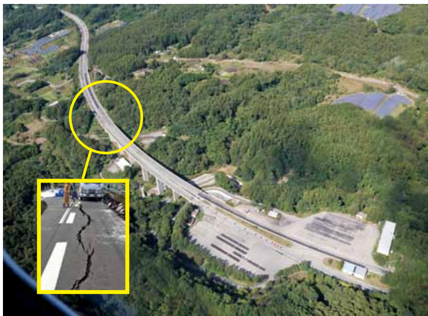
上信越道 碓氷軽井沢IC～佐久ICの盛土の変状(右上:夜間工事の様子、右下:対面通行の状況)
