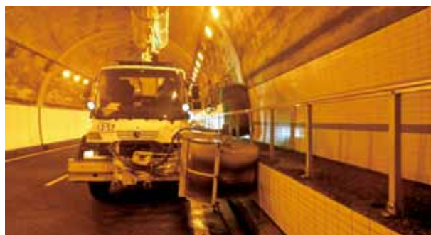
トンネル壁面の清掃
