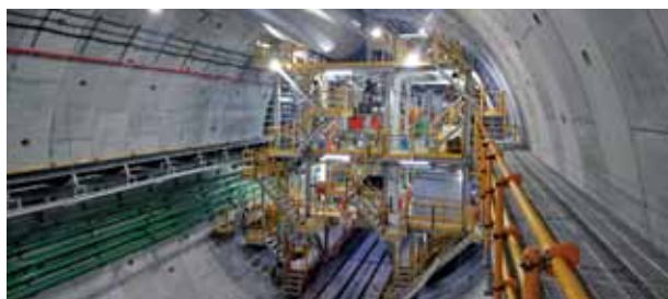
国内最大級のシールドトンネル内部
