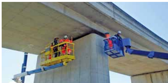
橋梁点検作業車などによる跨道橋点検
