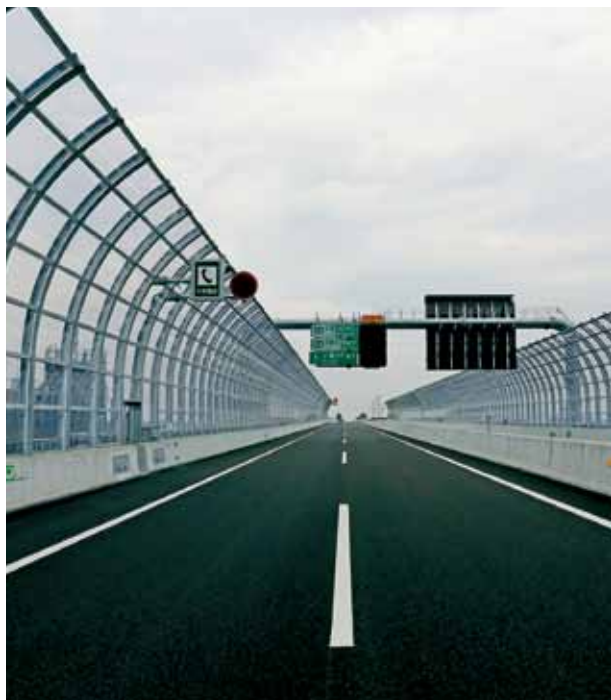
外環道(三郷南IC～高谷JCT)に設置した遮音壁
