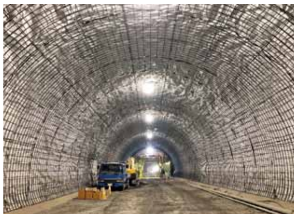
好間トンネルの工事状況
