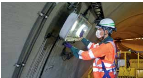
トンネル照明灯具の清掃
