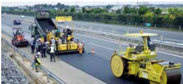
舗装補修作業
