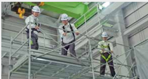
実習用足場による安全研修
