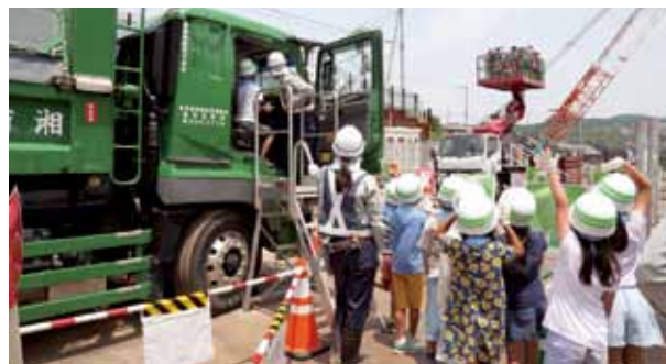
建設現場の見学会（横浜環状南線）
