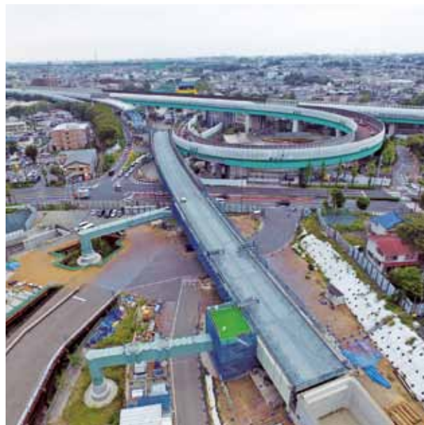
建設中の大泉 JCT
