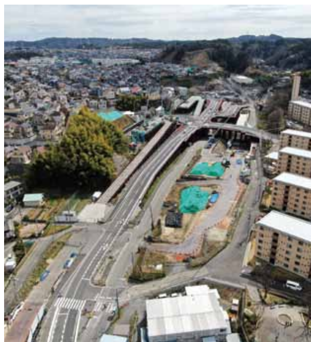
生活道路の迂回のために設置した仮橋
