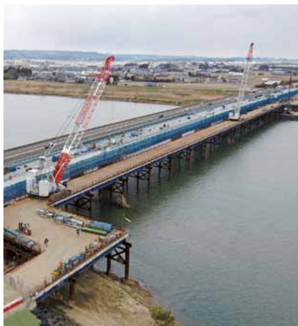
施工状況(阿武隈大橋)
