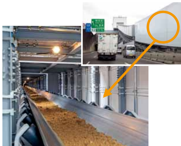
外環道の本線上に設置したベルトコンベア
