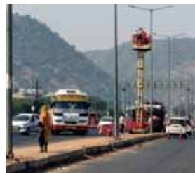
リフト車上からの画像撮影
