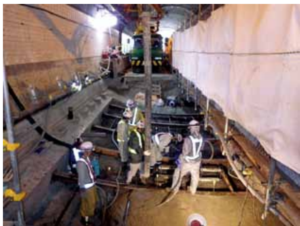
トンネルのインバート設置
