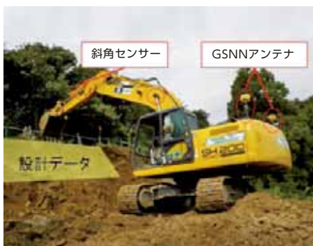
マシンガイダンスバックホウを活用した施工状況（センサーやアンテナから送られた情報が操縦席のガイダンスモニターに表示され、設計データどおりののり面の成形が可能となる）
