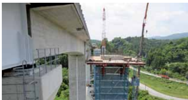
常磐道4車線化工事
