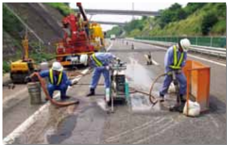
▲路面に生じたポットホール(小穴)の補修
