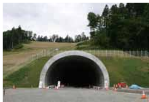
▲トンネルコンクリート
