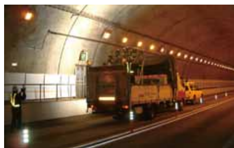
▲ CCDカメラによるトンネル内の点検
