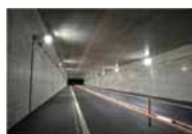
▲LEDのトンネル照明（道央道 鷲ノ木遺跡トンネル）
