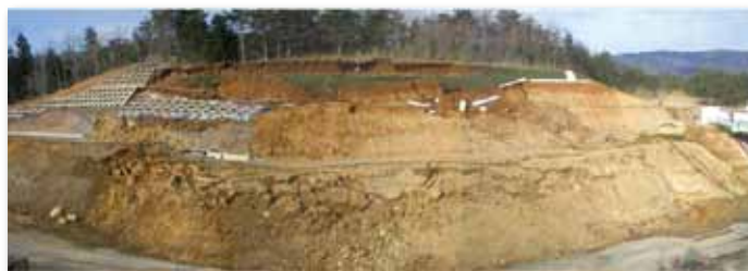
▲震災によるのり面の崩落
