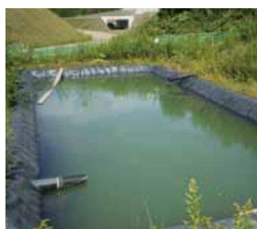
▲工事中湧水の濁水対策(沈砂池)
