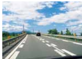
▲導流レーンマーク
