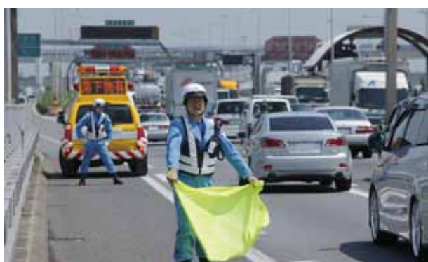
▲落下物の処理作業
