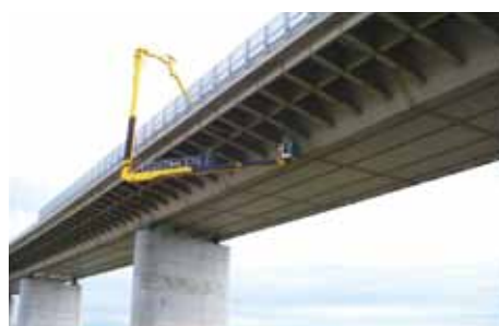
▲ 橋梁点検車による点検
