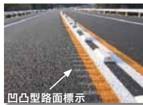
▲暫定2車線区間の車線逸脱防止対策(凹凸型路面標示)
